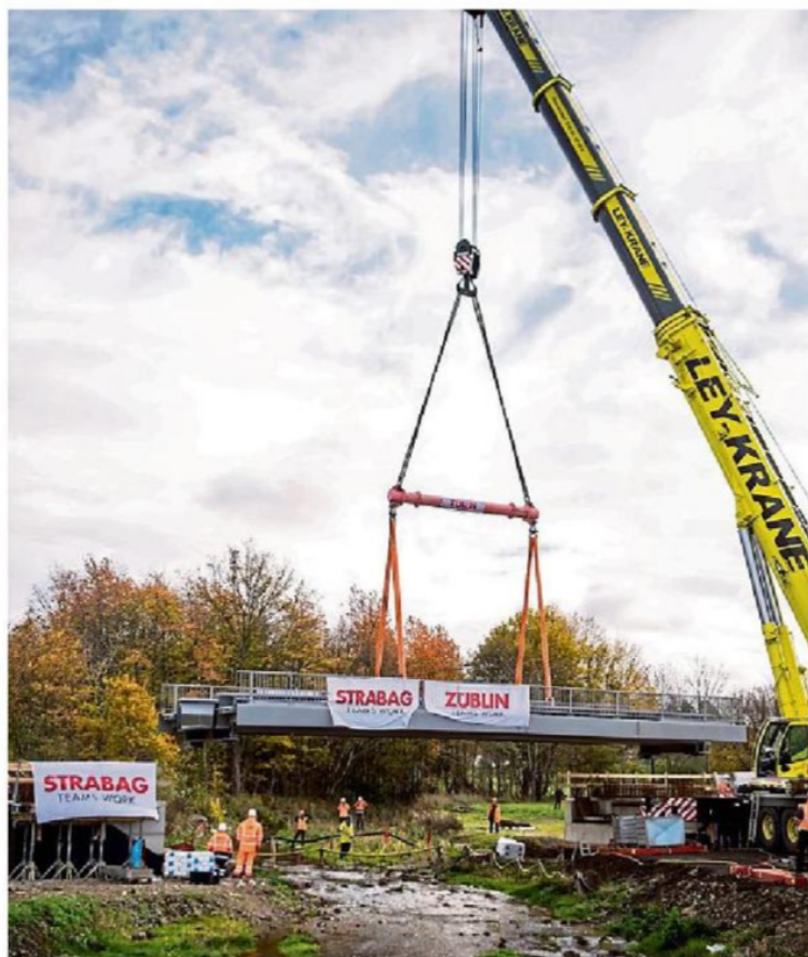
Millimeterarbeit: Die neue Eisenbahnbrücke bei Kirspenich ist eingesetzt worden. Bis die erste Züge darüberfahren werden, wird aber noch mehr als ein Jahr vergehen. Fotos: Tom Steinicke
